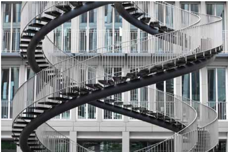
Foto 4: Flexibiliteit van besluitvorming. De trap is van het KPMG gebouw te München.
